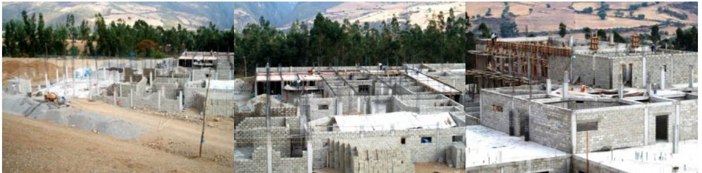
340 Stützen sind fertig
