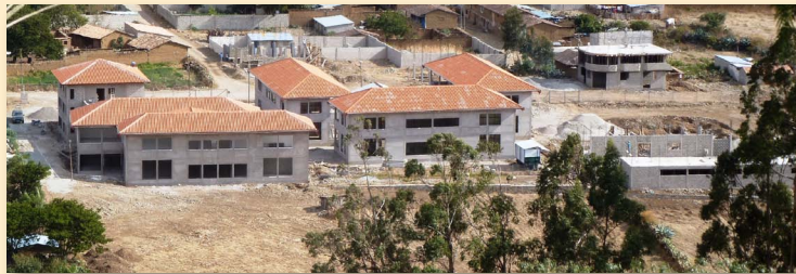
▲ Blick auf die Schule von oben. Rechts entsteht derzeit die Sporthalle.
