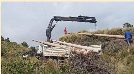
▲ Ein Kranwagen errichtet Masten für die Stromleitung unseres Sendeturms in Abancay.
