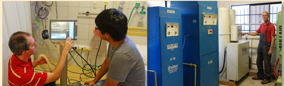
▲ Markus Klatt und Cesar Martel stellen ein weiteres Beatmungsgerät auf. ▲ Nicht nur Oebele de Haan freut sich über die drei Sauerstoffgeneratoren. Sie produzieren fast 250 Liter O 2 pro Minute.
