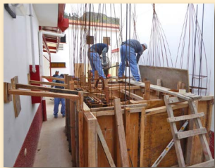
▲ Arbeiten am Schacht
