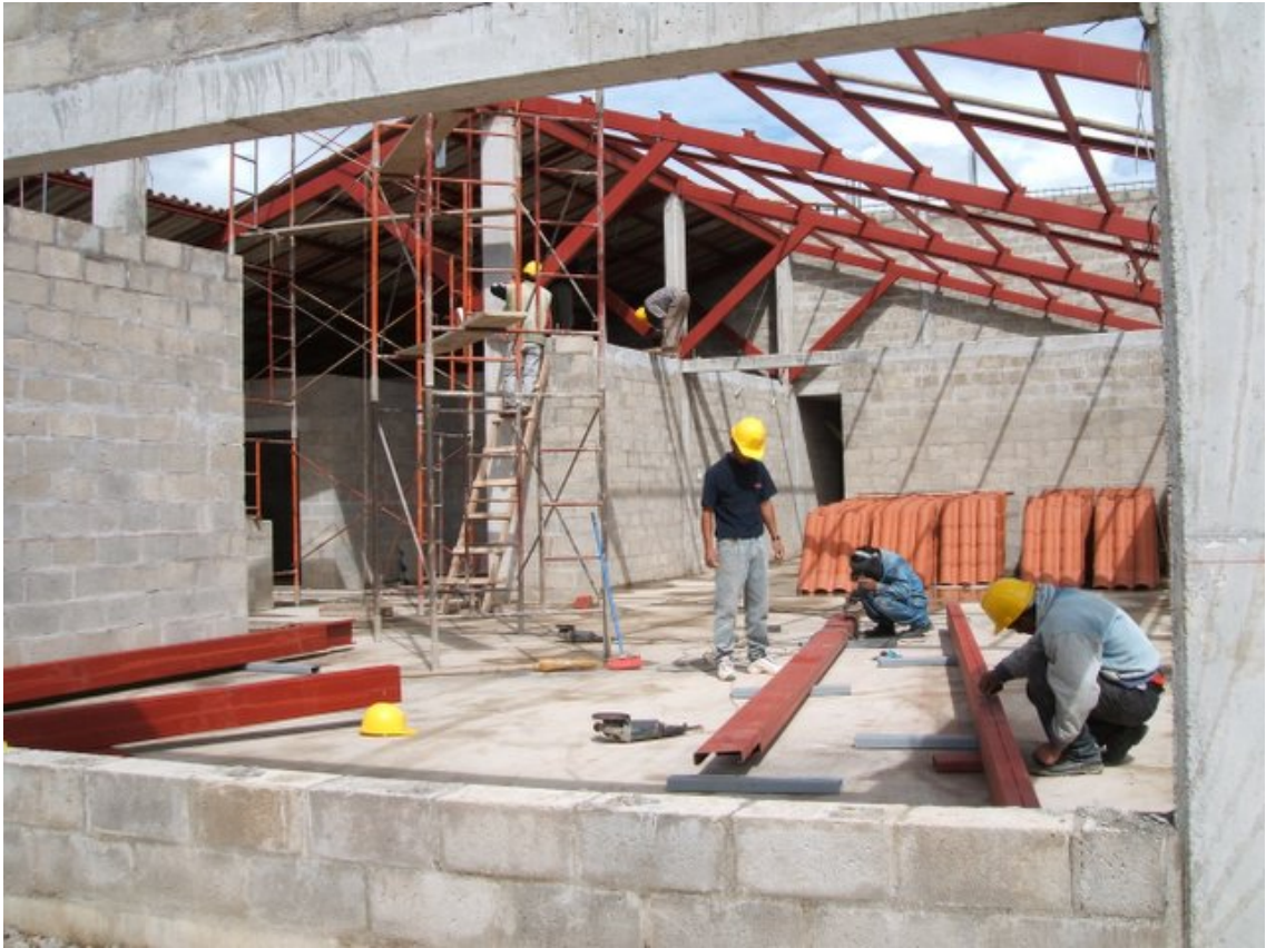
Abbildung 5: Bauarbeiter bei der Dachkonstruktion
