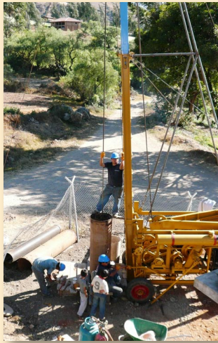
▲ Große Rohre wurden bis auf 63 Meter Tiefe versenkt.
