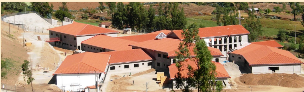
▲ Seitenansicht des Spitals - im Hintergrund das Amphitheater
