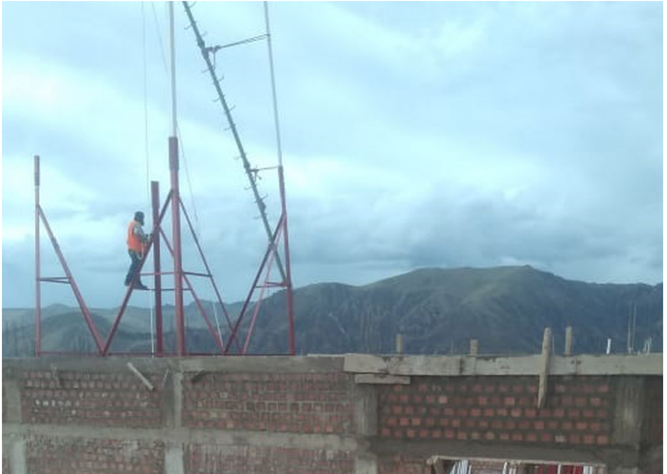
Gestern in der Dämmerung. Die Techniker beginnen mit dem Stahlgerüst.
