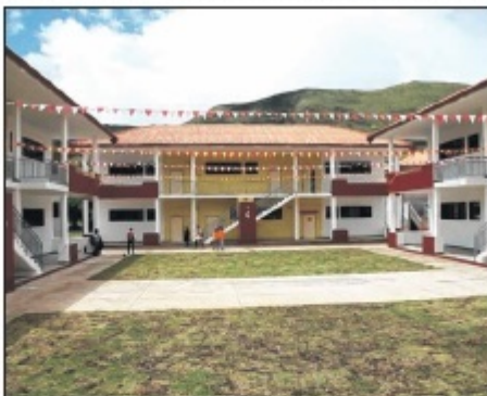
Die Grundschule ist fertig – Projekt Nummer zwei.
