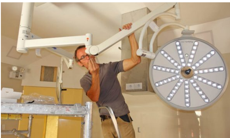
Matthias Kügler beim Aufhängen einer Operationslampe
