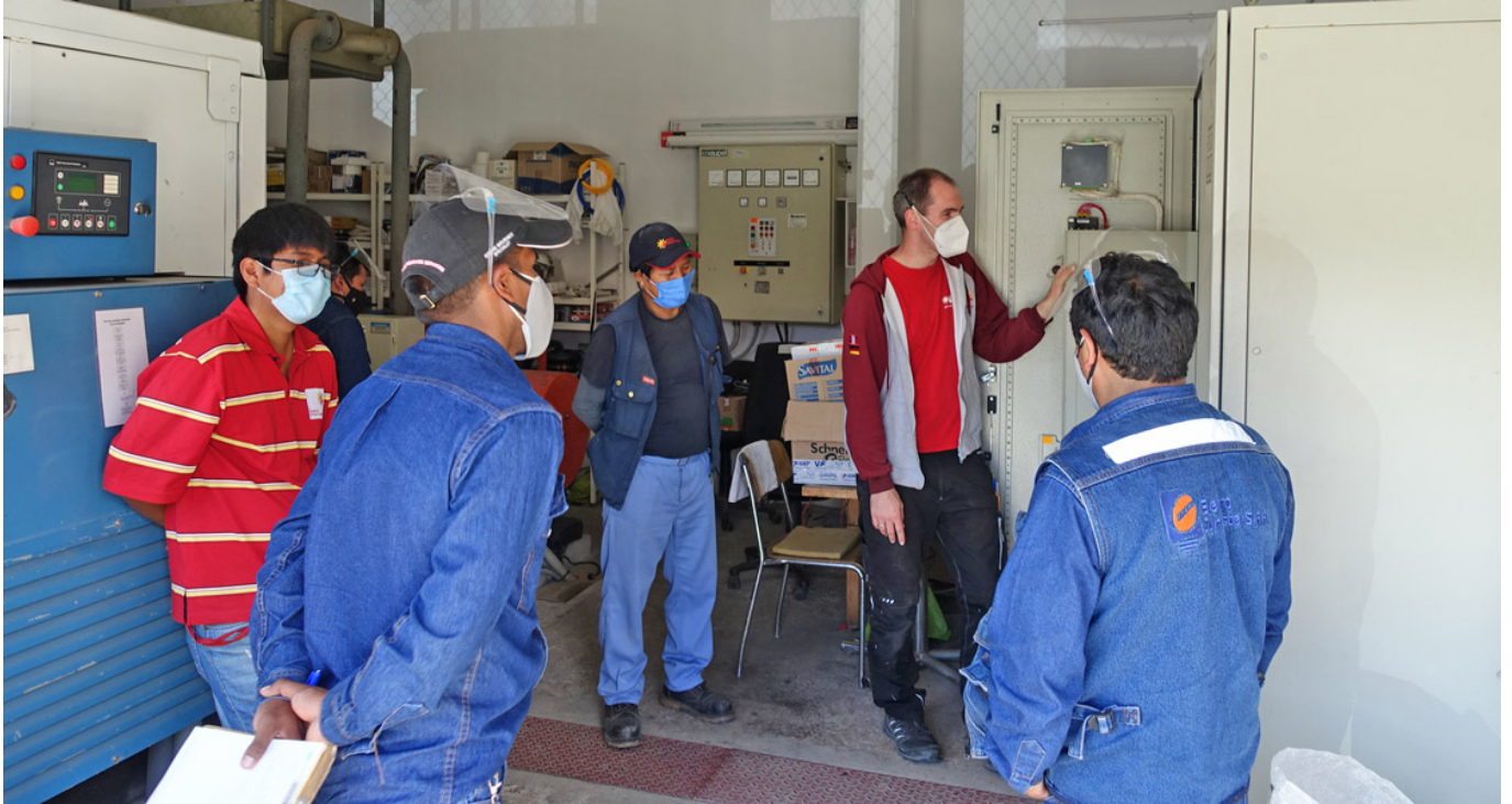
Markus Klatt muestra al grupo de ingenieros, las distintas tableros de control del hospital.
