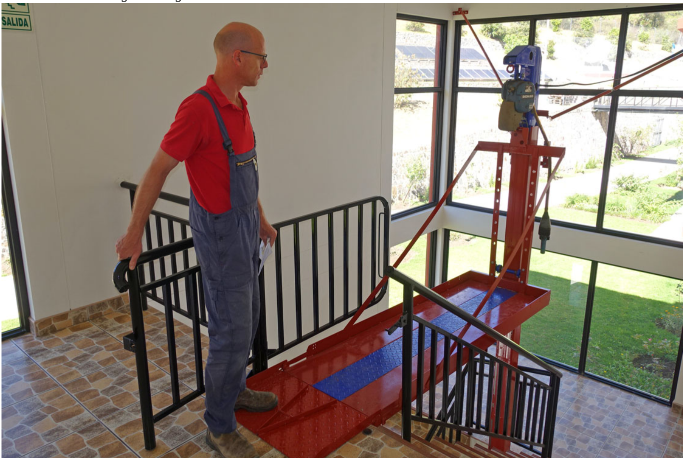
Ein rustikaler Aufzug im hinteren Treppenhaus. Das Türchen im Geländer lässt sich öffnen, damit eine Patiententrage auf die Plattform fahren kann. Der Sicherheitskasten fehlt noch.
