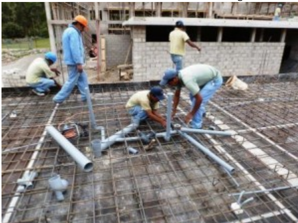
Sanitärinstallation in der Decke
