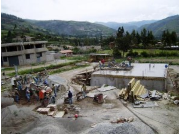
Die Kellerdecke vom Kindergarten wird betoniert.
