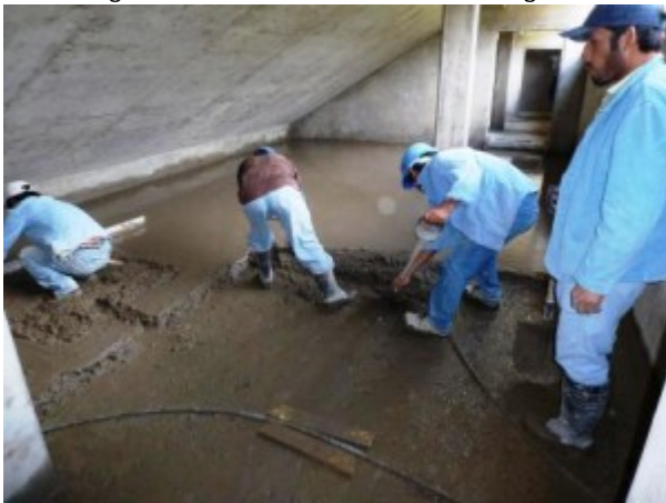
Der Estrich unter der Tribüne wird eingebracht.
