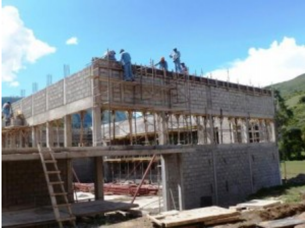
Der Ringbalken für die Attika wird eingeschalt.
