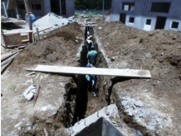
Grabenaushub von Hand für die Entwässerung
