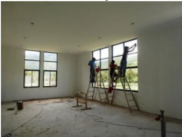
Fenstermontage im Physiksaal
