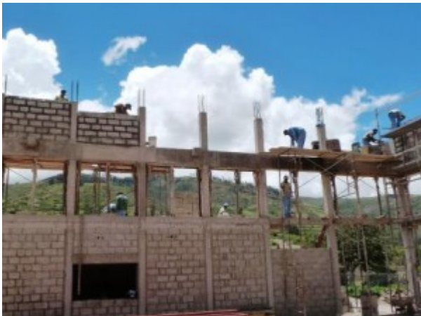
Mauerarbeiten an der Attika Sporthalle
