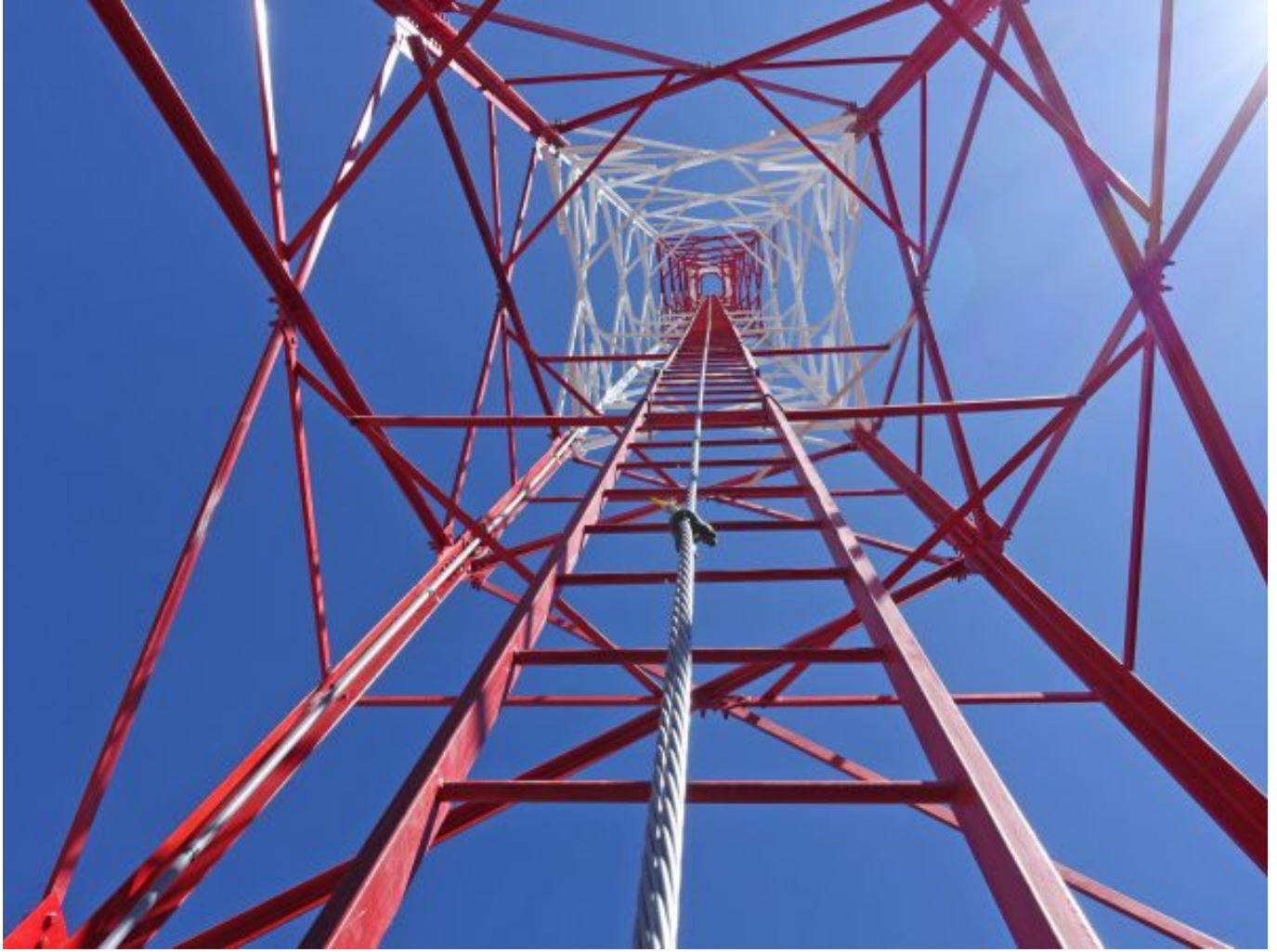
Perpectiva desde 40m de altura en la torre
