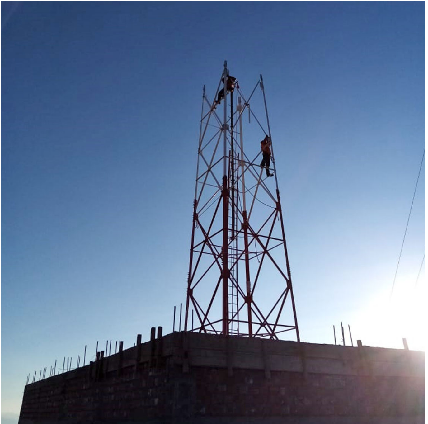
Die Arbeiten am 40-m-hohen-Turm sollen am Mittwoch abgeschlossen werden.
